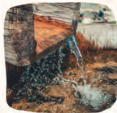
Installer des gouttières et un récupérateur d'eau de pluie
